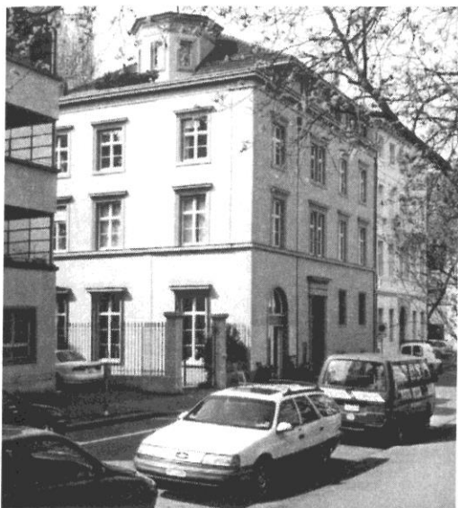
St. Alban-Vorstadt 110, Basel Sanierung/Renovation, Umbau Wohn- und Geschäftshaus
