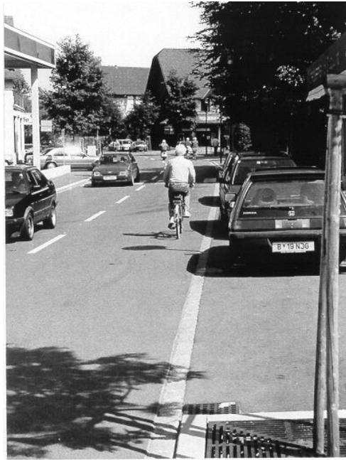
Abbildung 8: Die Regellösung auf Hauptverkehrsstrassen sollte die Führung des Radverkehrs auf Radstreifen sein. Reicht dafür der Raum nicht aus, sind Mischverkehrs- oder Speziallösungen gefragt. Mischverkehrslösungen sind in Abhängigkeit von der verfügbaren Querschnittsbreite auch bei hohen Verkehrsbelastungen möglich, wenn der Schwerverkehrsanteil nicht zu hoch ist. Die Abbildung zeigt eine Mischverkehrslösung auf einer Hauptstrasse in Lustenau/A. Beim Umbau konnten kleine Flächengewinne zugunsten des Fussverkehrs und der Strassenraumgestaltung realisiert werden. Die mit 10'000 Fz DTV und einem Busanteil von ca. 3% belegte Fahrbahn ist 6 m breit und mit einer Geschwindigkeitsbeschränkung von 40 km/h signalisiert.
