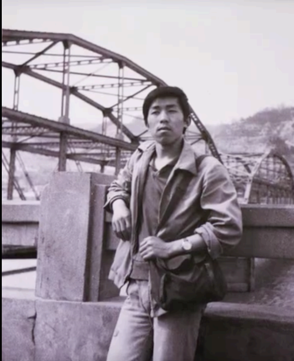
Yang Zhichao in Lanzhou (Zhongshan Bridge)
