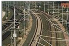
Gleise der DB Netz AG
