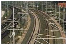
Gleise der DB Netz AG
